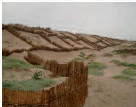
Photo 5.10 Brise-vent en spartine installé. Le premier rang est une ganivelle de clôture. © Carlos Ley
