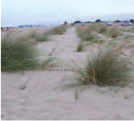
Photo A.19 Recouvrement des ganivelles par le sable et installation de la végétation.
