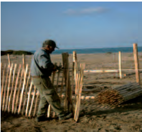
Photo A.17 Travaux de mise en place des ganivelles. © Melhaoui Mohammed / Latifa Elhafid
