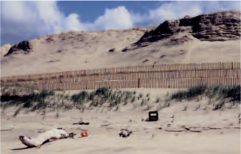
Photo 5.11 Pose de ganivelles basses en France, sur la côte d'Aquitaine, nord de la Gironde. © ONF/JF Office National des Forêts/Jean Favennec
