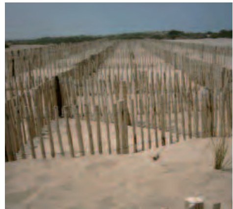
Photo A.18 Ganivelles installés. © Melhaoui Mohammed / Latifa Elhafid
