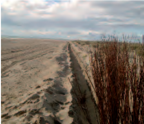
Photo 5.8 Installation des brise-vent en osier. Creusement d'un fossé et mise en place. © Carlos Ley
