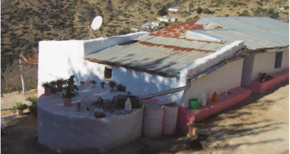
أ) نظام تخزين مياه الأمطار: قنوات، خزان ومضخة، ب) سقف وقناة وخزان
