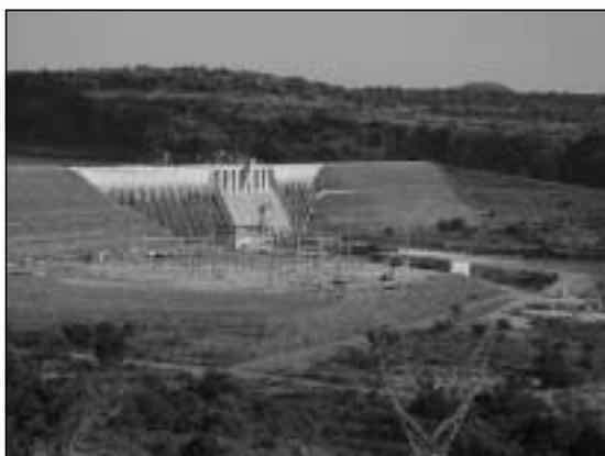
La hauteur du barrage est de 65m. Il comporte huit passes de neuf mètres équipées de vannes-segments, sept pertuis de 3,8m x 4,8 également équipés de vannes segments, cinq prises d'eau de 14m x 15,4m à l'entrée, prolongées par cinq conduites de 4,8m de diamètre.
