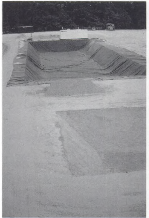
Bâche de protection dans la fosse principale de Mafoua I
