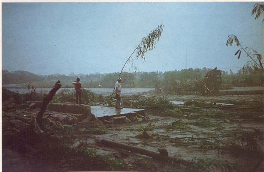
4.—Destrucción permanente de las principales vías que unen la costa del Pacífico con la ciudad capital, provocada por las fuertes escorrentías.
