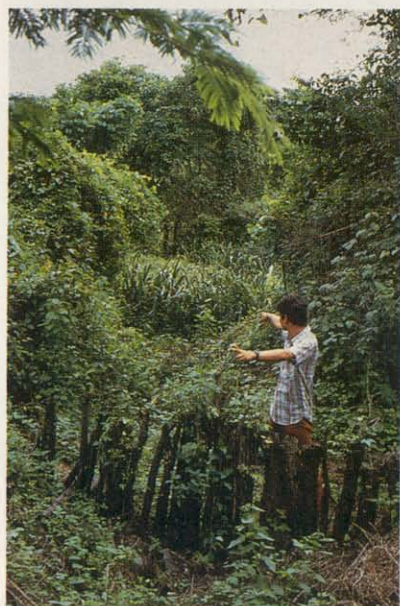
9.—Control de escurrimiento en el pie de monte, mediante la construcción de diques con materiales locales
