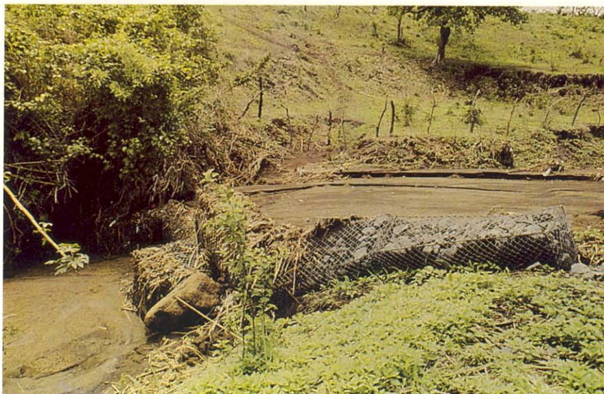
8.—Obras de retención que han dado buenos resultados en la estabilización de cárcavas.
