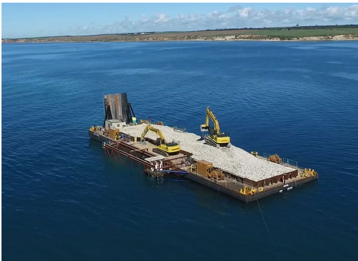
Une barge de construction décharge des rochers pour la restauration de récifs (voir Encadré 11 pour plus de détails). Australie Photo : Adam Bolton.
