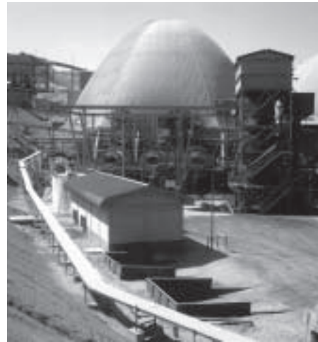
Contención del polvo en el desierto de Atacama, Chile. Foto: Anglo American
