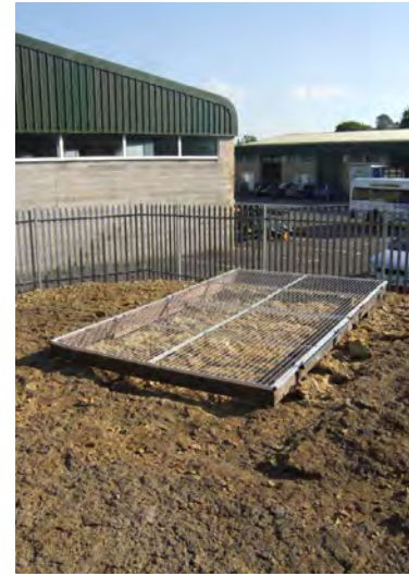
غطاء شبكي ملحوم لحماية طبقات المتحجرات المكشوفة © جوناثان لارود
