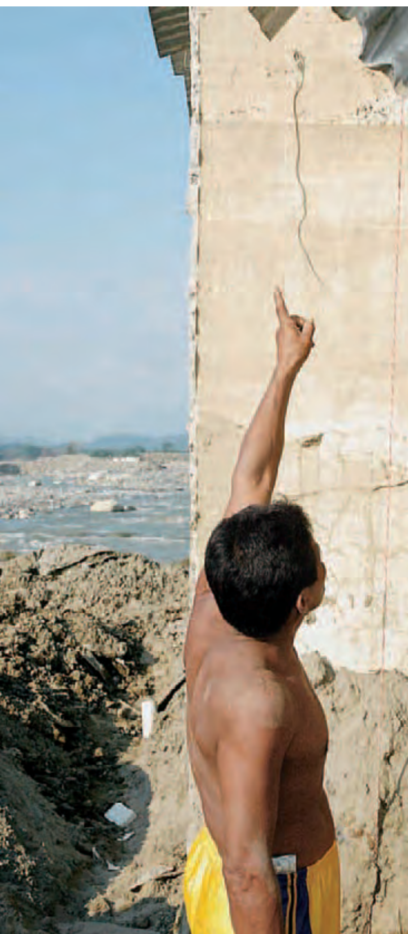
Un vecino de la zona señala la marca que dejó el barro ya en el área de construcción que se levanta más de cinco metros sobre el nivel habitual del río Coatán en la Colonia Obrera. En esta comunidad varias personas perdieron la vida y muchas familias quedaron sin hogar. Fotografía: Marco A. Calvo F. / UICN
