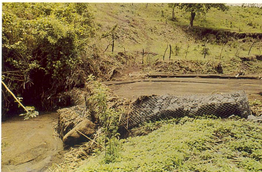
8.—Obras de retención que han dado buenos resultados en la estabilización de cárcavas.
