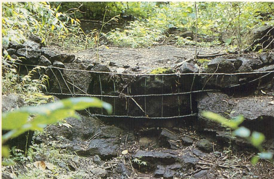
9.—Control de escurrimiento en el pie de monte, mediante la construcción de diques con materiales locales
