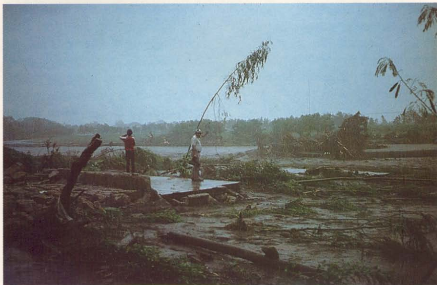
4.—Destrucción permanente de las principales vías que unen la costa del Pacífico con la ciudad capital, provocada por las fuertes escorrentías.
